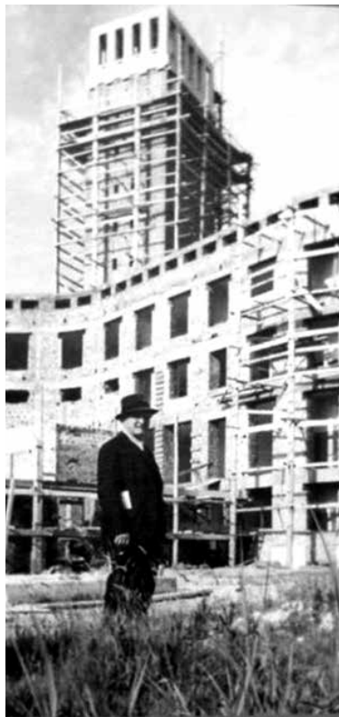
L'Architetto Oriolo Frezzotti durante la costruzione della Sede della Federazione P.N.F (oggi Palazzo M)
